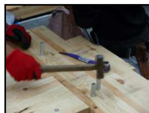
(5) 柱頭部組立 ドリフトピン打ち込み
