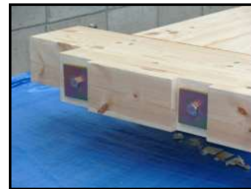
(8) 柱頭部引き寄せボルト 完了
