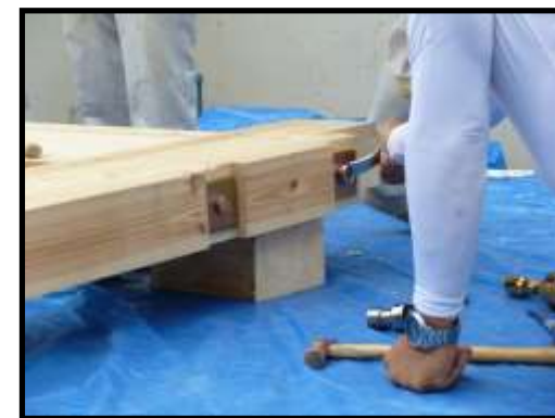
(7) 柱頭部引き寄せボルト 締め付け
