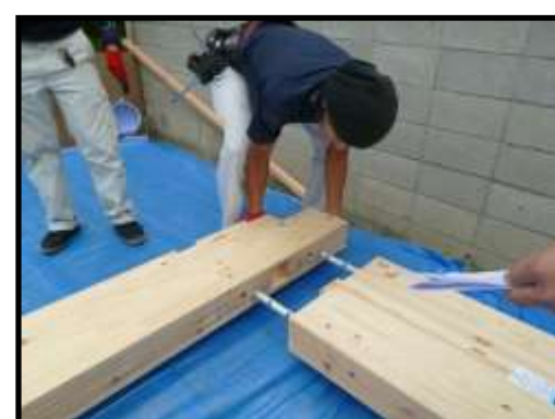
(4) 柱頭部組立 柱・梁材 差込
