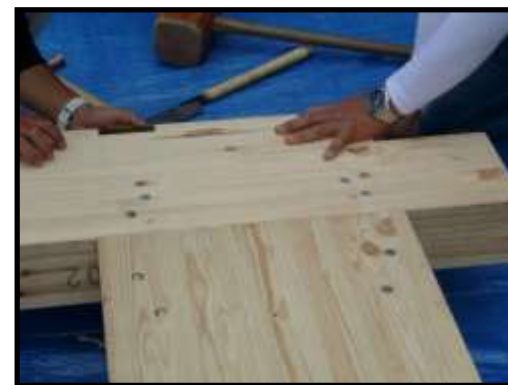
(6) 柱頭部組立 ドリフトピン打ち込み完了
