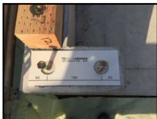
(1) 基礎アンカーボルト 設置位置確認
